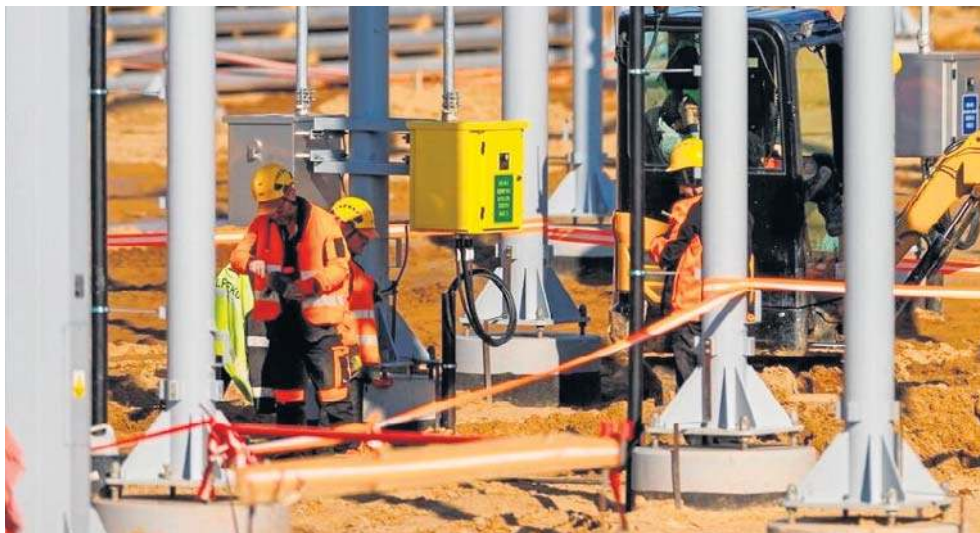
Stacja elektroenergetyczna Choczewo na ostatnim etapie budowy
