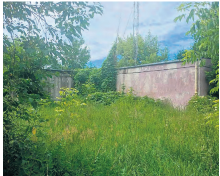
Stacja Uzdatniania Wody w Kamienicy powstanie w miejscu starej instalacji sprzed pół wieku. – Nie będzie wiercenia nowych studni głębinowych, wykorzystamy te, które już istnieją – mówi Wiesław Błach.
