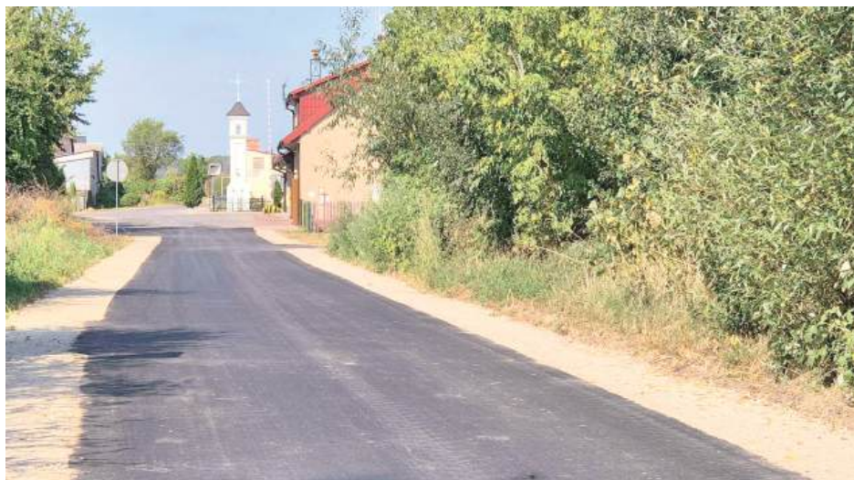
W Osinach dokończono fragment ul. Szkolnej. Teraz na całej długości jest pokryta asfaltem
