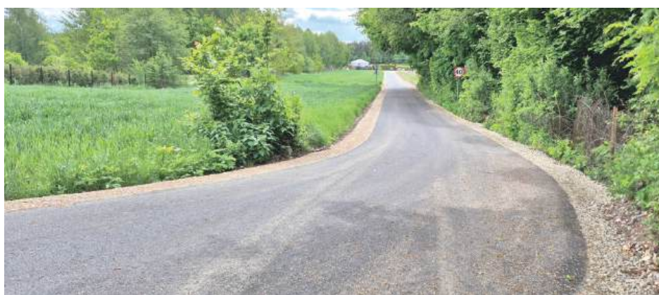
Tak prezentuje się fragment ul. Pałacowej w Żyrzynie. To był drugi etap realizacji. Długość zmodernizowanego odcinka wynosi 387 metrów
