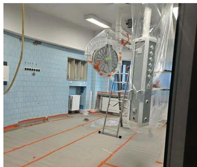
W szpitalu trwa remont bloku operacyjnego
