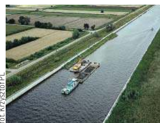
Do końca sierpnia 2025 roku mają potrwać prace pogłębiarskie na rzece Elbląg
