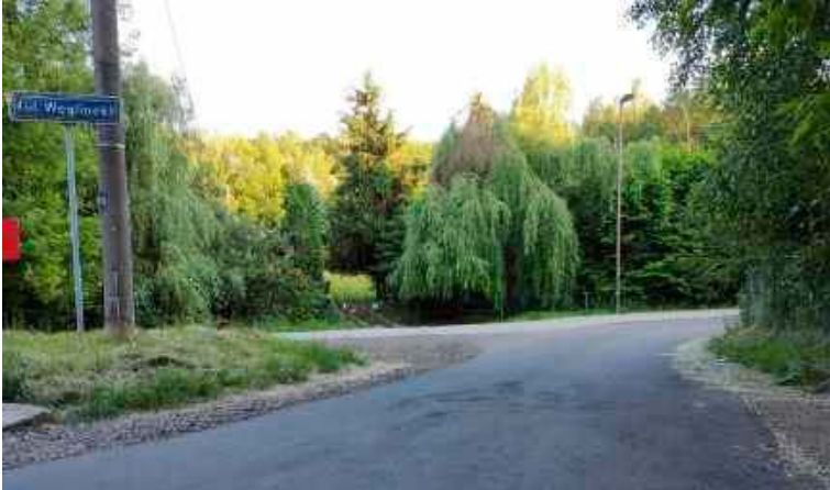
Do stacji Lublin-Zachodni wreszcie możemy dojechać asfaltową drogą
