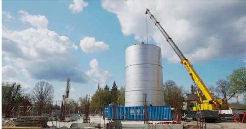
Na placu budowy trwa montaż kolejnych urządzeń
