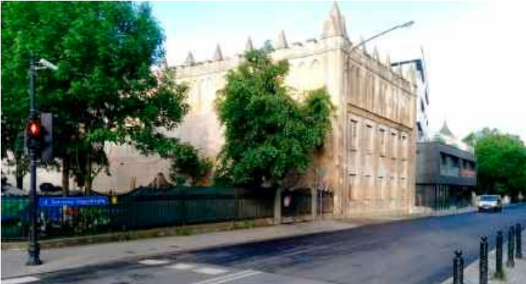
Remont ulicy i chodnika odbył się na koszt dewelopera
