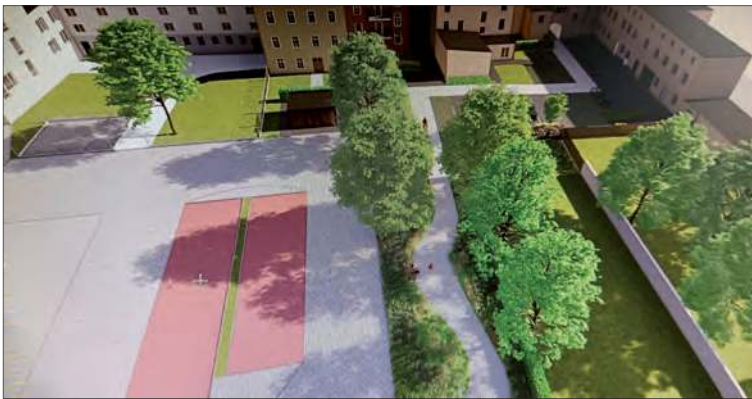
Podwórko przy ul. Piastowskiej, przy parkingu Biedronki
