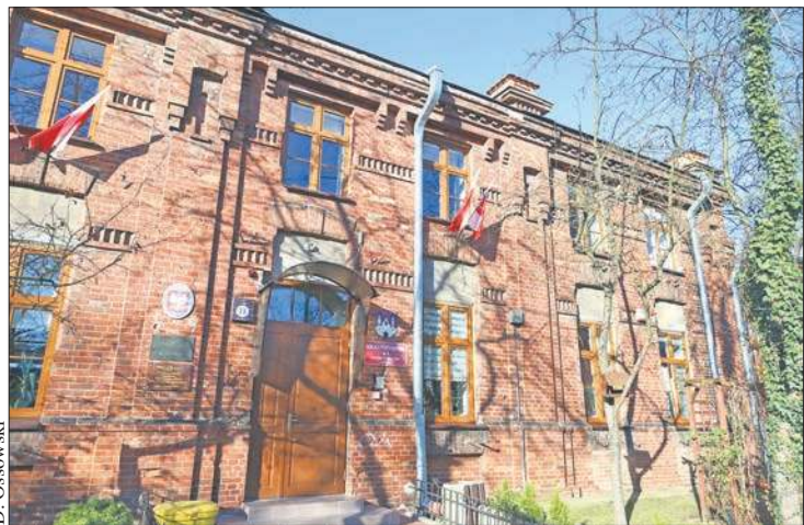
W najstarszej plockiej podstawówce – Szkole Podstawowej nr 6 – trwa renowacja zabytkowej części budynku i remont sali gimnastycznej
