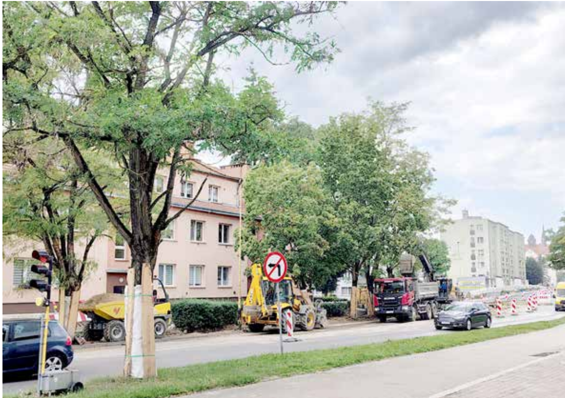
Drzewa w głębi do wycinki - przeszkoda dla ronda będącego samym przeszkodą
