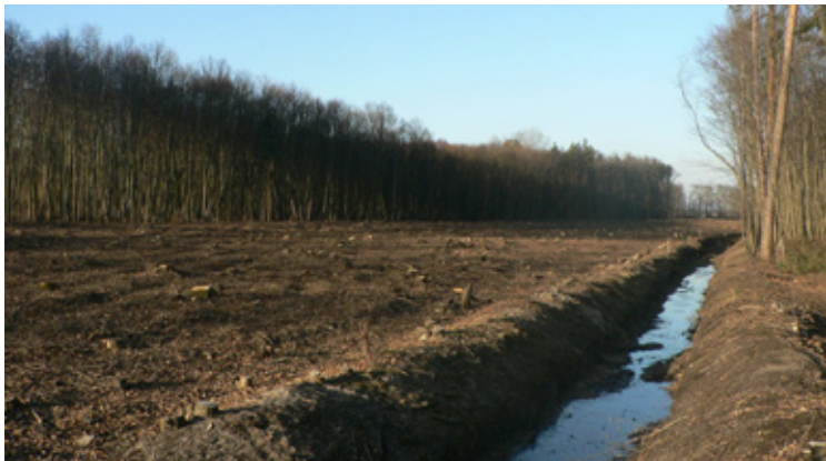
Wylesienie gruntu pod budowę wału powodziowego Domaszków – Tarchalice (grudzień 2013 r.)
