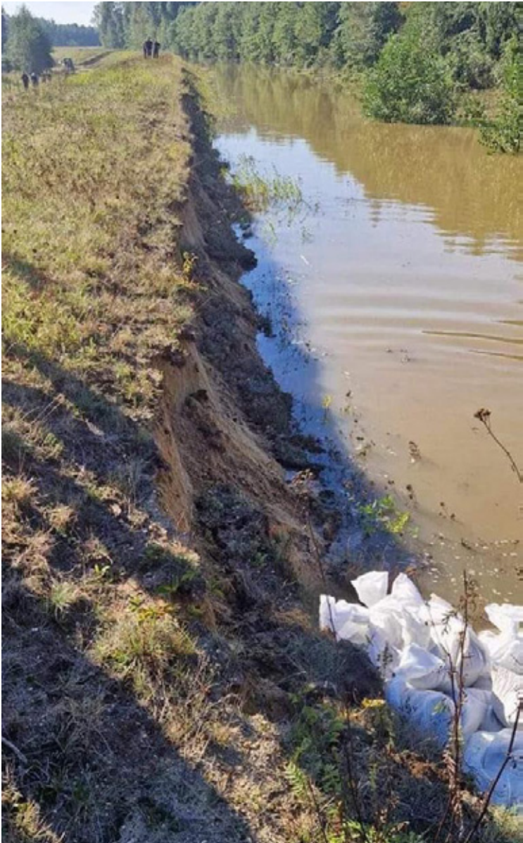
Woda „podbierająca” wał polderu zalewowego (21 września 2024 r.)
