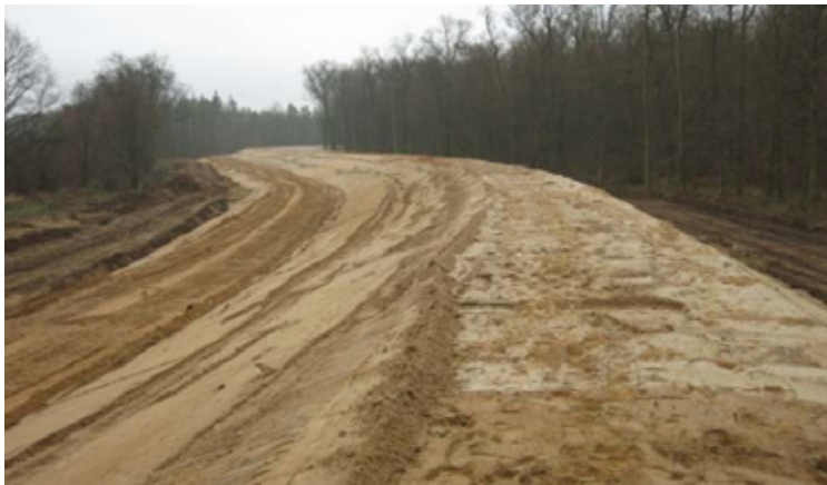
Budowa wału powodziowego w ramach inwestycji polderu zalewowego Domaszków – Tarchalice (czerwiec 2014 r.)
