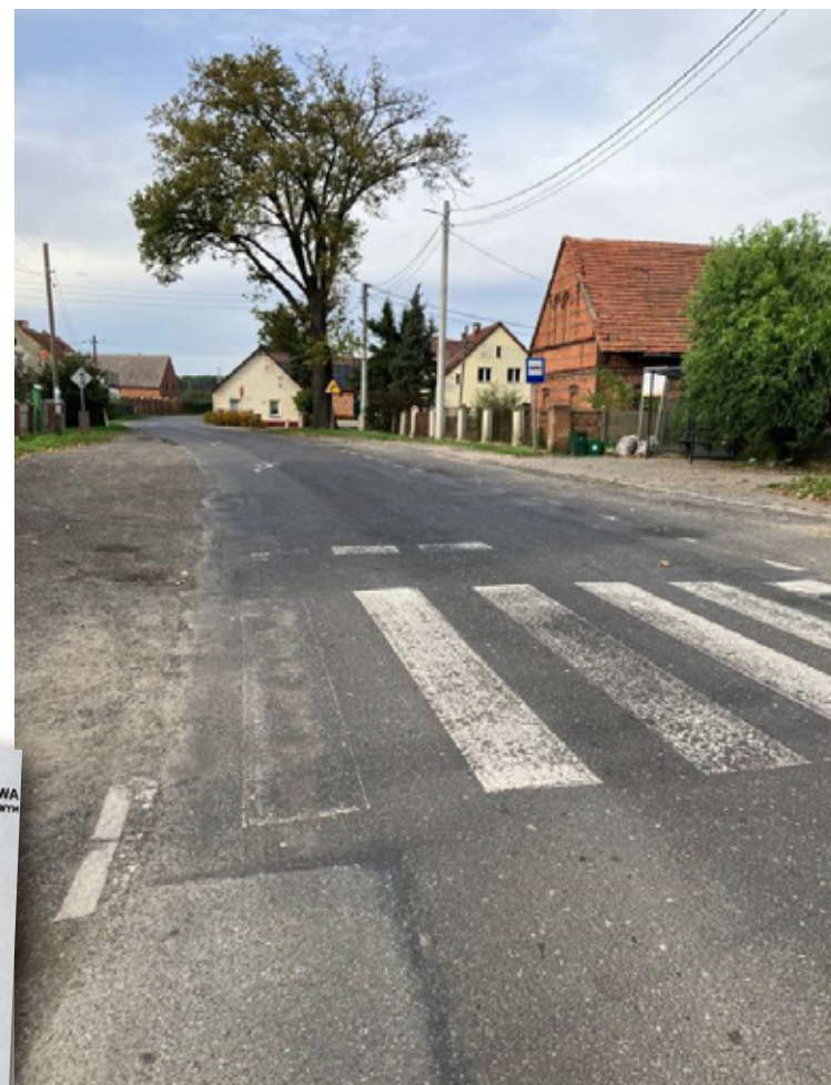
Ta część drogi wojewódzkiej 338 w Starym Wołowie już niedługo zostanie wyremontowana
