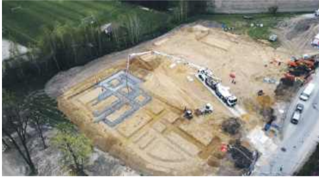
Ruszyły prace nad fundamentami nowej szkoły
