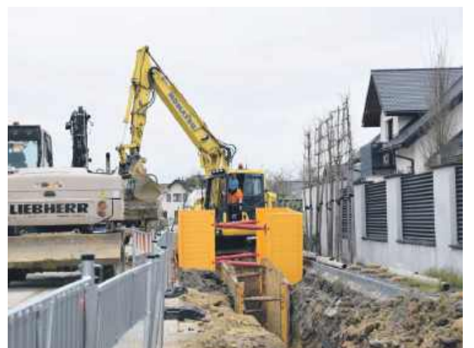
Trwa budowa kanalizacji sanitarnej w Krzyżanowicach
