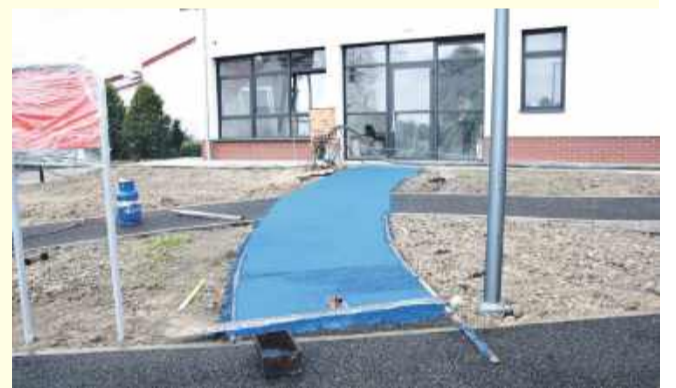
Nowa nawierzchnia pod urządzenia na placu zabaw
