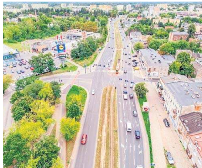
Trasa na Chojny będzie zmodernizowana. Miasto ogłosiło przetarg na remont torów tramwajowych
