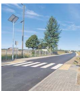
Droga powiatowa Bobrek – Brzeska Wola została przebudowana na odcinku około 1,8 kilometra.
