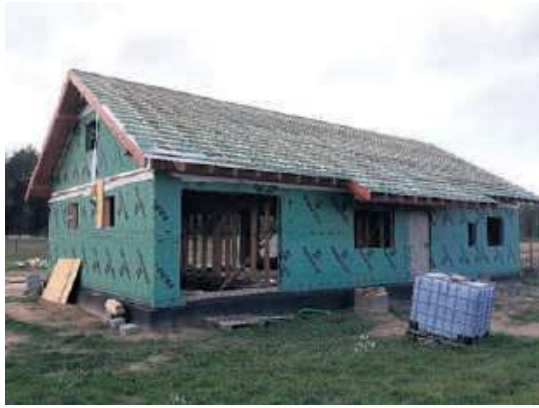
Budowa dachu od podstaw, na nowym budynku, jest sprawą prostszą i tańszą. Remont starego dachu jest trudniejszy i czasami kosztowniejszy.
