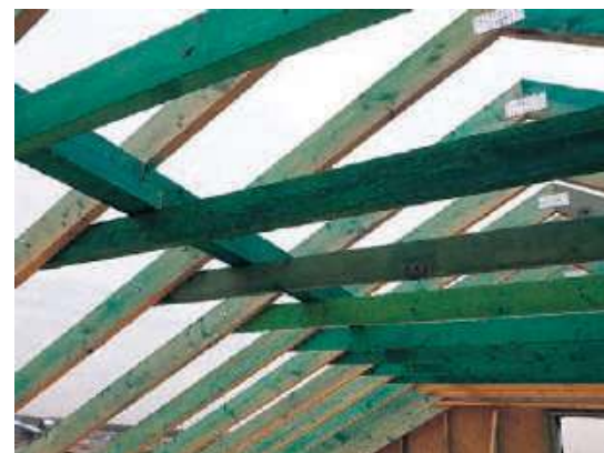
Więźba dachowa jest ważną częścią całej konstrukcji.
