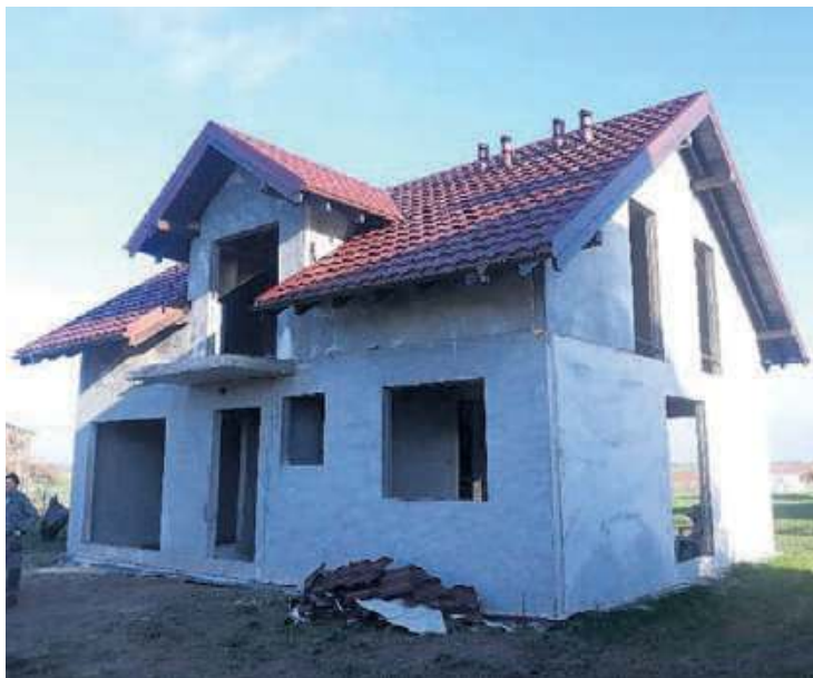
Dach sztyty na miarę.
