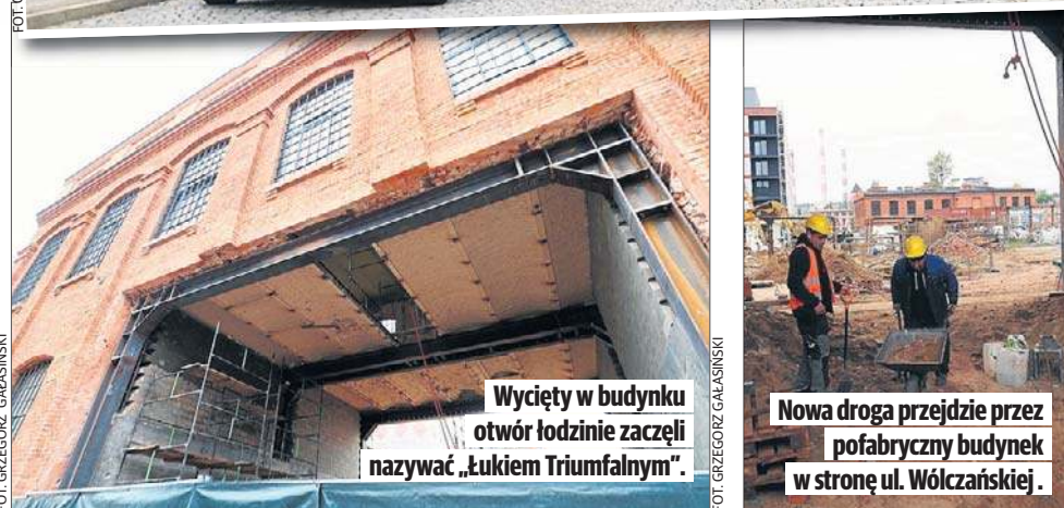
Budynek dawnej suszarni fabryki Geyera z wyciętym otworem na nową ulicę.
