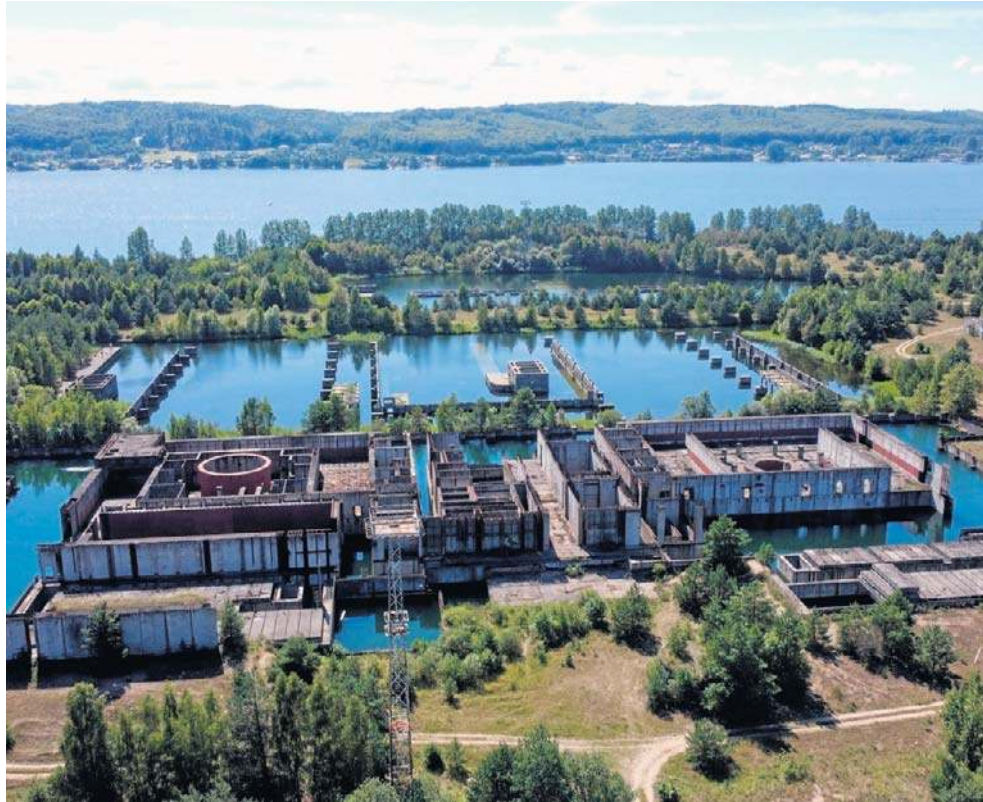
17 grudnia 1990 r. rząd Tadeusza Mazowieckiego podjął uchwałę o postawieniu inwestycji „Elektrownia Jądrowa Żarnowiec w budowie” w stan likwidacji
