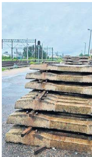
Na odcinku 17,5 km pracownicy PLK wymienia tor, wyremontują 12 przejazdów kolejowo-drogowych.
