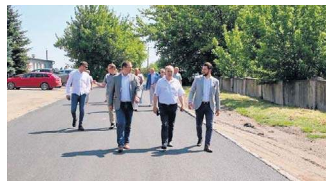
Remont drogi w Lechlinie dobiegł końca.
