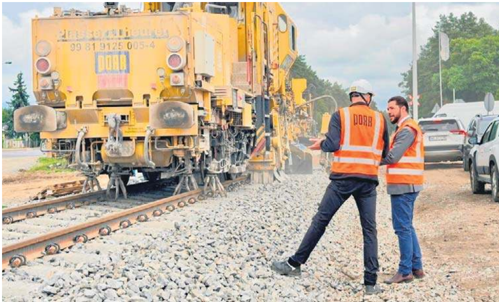
Trwa rewitalizacja linii kolejowej na odcinku Wągrowiec - Gołańcz - granica województwa
