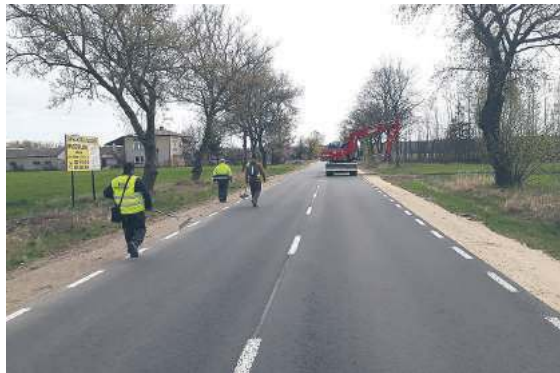
Na drodze powiatowej trwają ostatnie prace porządkowe
