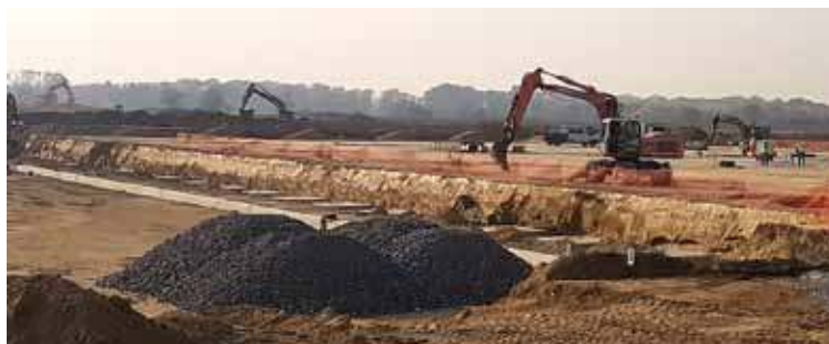
Inwestor Waimea Logistic Park Stargard przekazał teren budowy generalnemu wykonawcy, firmie Eastwave Building Company
