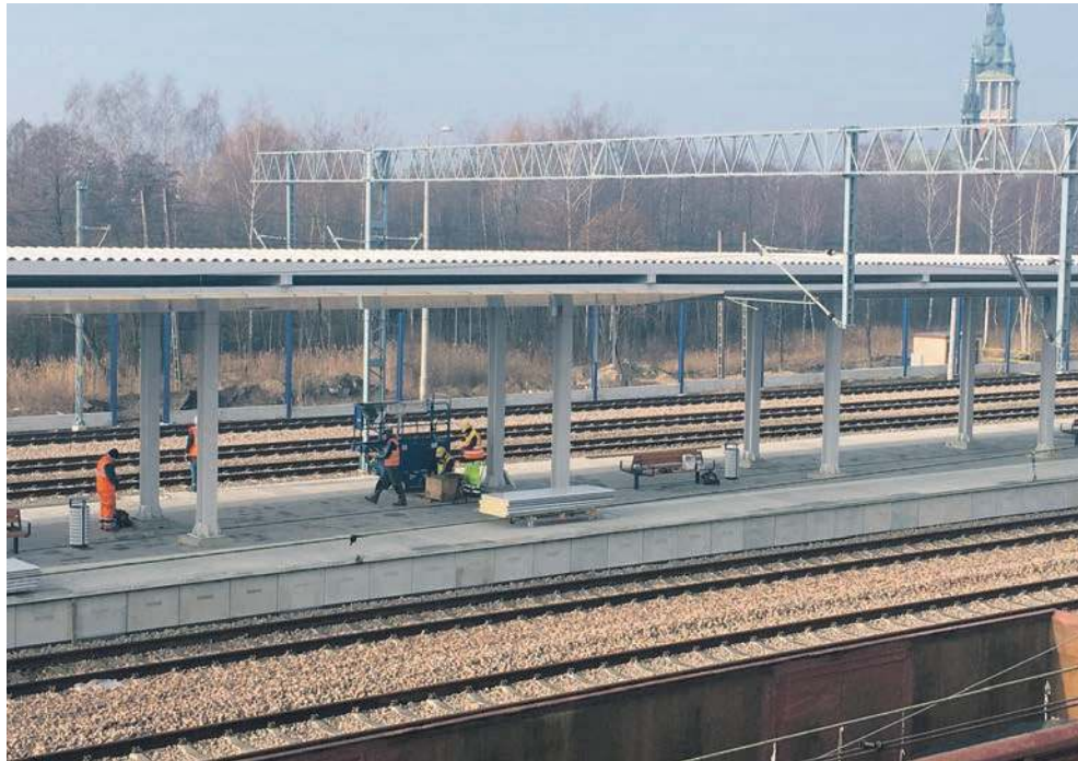
Na peronie trwają już ostatnie prace
