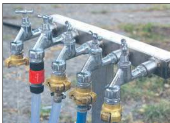
Gmina Zamość otrzymała 2,2 mln zł na inwestycje w budowę sieci wodociągowej w miejscowości Płoskie. Fot. pixabay.com
