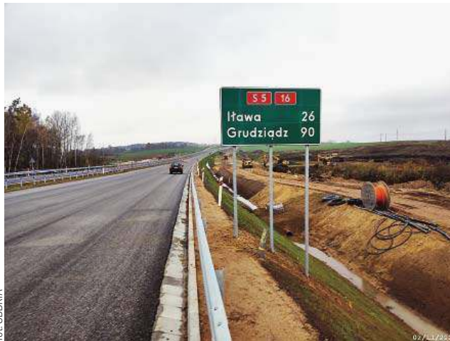
Odcinek S5 Ornowo-Wirwajdy ma być udostępniony kierowcom pod koniec tego roku
