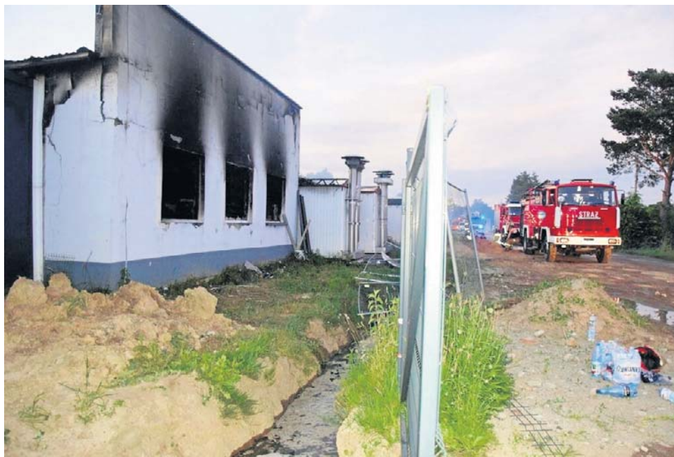
Miejsce akcji gaśniczej w Charnowie. Z pożarem walczyło 200 strażaków
