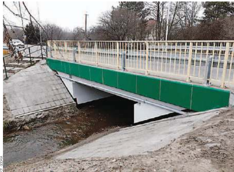
Przeprowadzone roboty remontowe dotyczyły zabezpieczenia dźwigarów i strefy podparcia mostu
