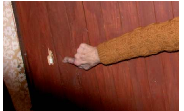
Otwór wylotowy po wewnętrznej stronie drzwi
