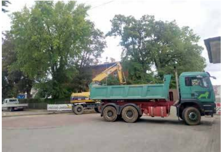
Prace przy samym dworcu prowadzone przez PRD rozpoczęły się w poniedziałek
