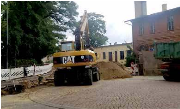
I tu potrzebne są prace ziemne
