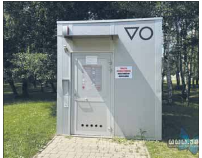
Toaleta w Parku Podłęże zdewastowana
