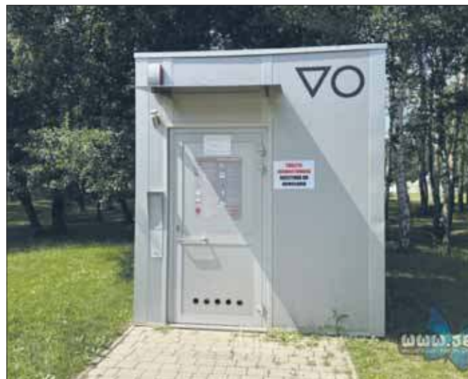
Toaleta w Parku Podłęże zdewastowana
