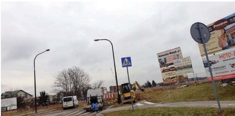
Drogowcy już weszli na plac budowy I etapu NSZZ „Solidarność”
