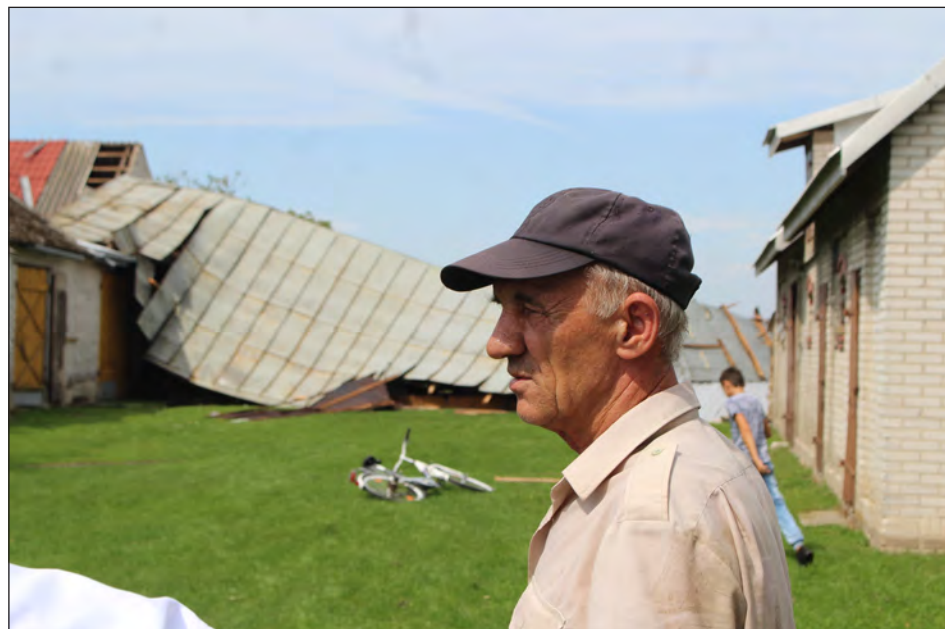
✚ - Wszystko trwało kilka minut. W tym czasie trąba powietrzna powaliła stodołę, uszkodziła budynek gospodarczy oraz okna w domu i dach - mówi Ryszard Mućka
