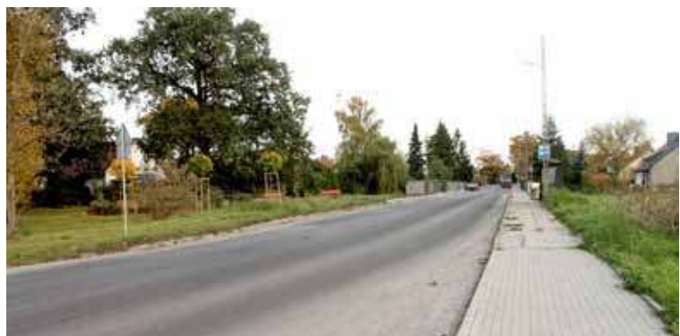
W ramach modernizacji zostanie również przebudowana część ulicy Lelewela
