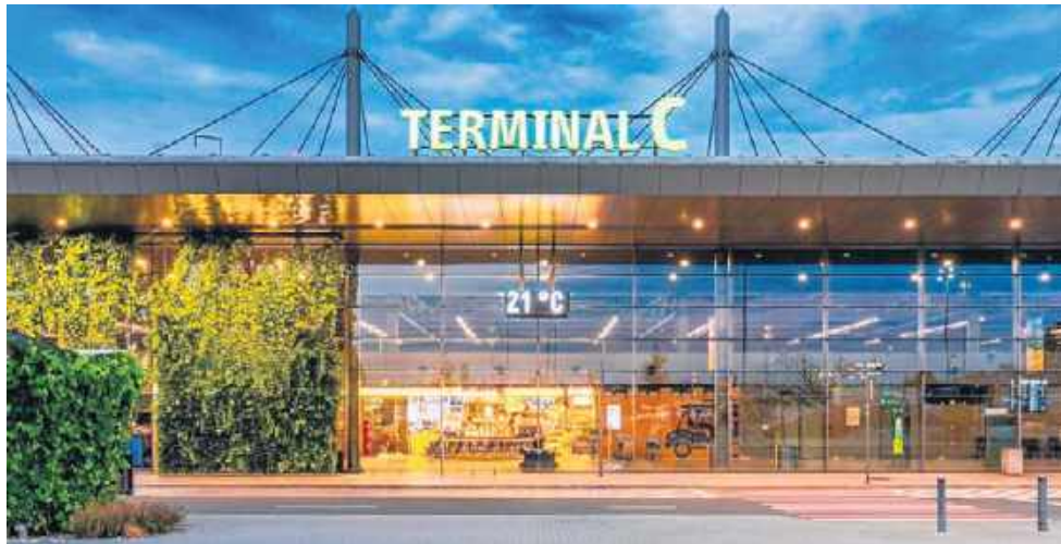
Oddanie powiększonego terminalu do użytku zaplanowano na połowę 2027
