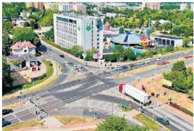
Skrzyżowanie jest niewydolne. Nowe rondo poprawi płynność i przepustowość ruchu w tym miejscu
