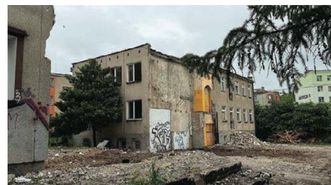
Widoczny efekt prac: wyburzenie łącznika między bryłami budynku wyraźnie otworzyło i doświetliło przestrzeń
