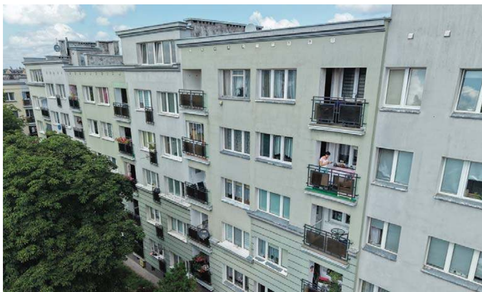
W budynkach przy ul. Królowej Jadwigi zamontowano nowe, jednakowe balustrady
