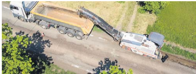
Trwa największa modernizacja nawierzchni na drogach wojewódzkich w Łódzkiem
