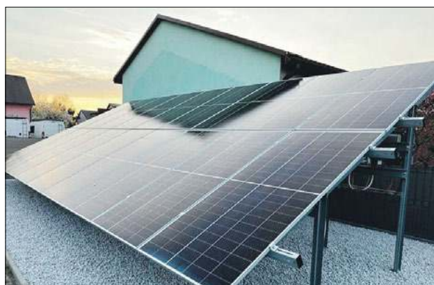
PVTIM montuje instalacje elektryczne i fotowoltaiczne dla domu, rolnictwa i przemysłu
