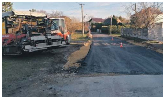
Trwa remont ul. Olszynka
