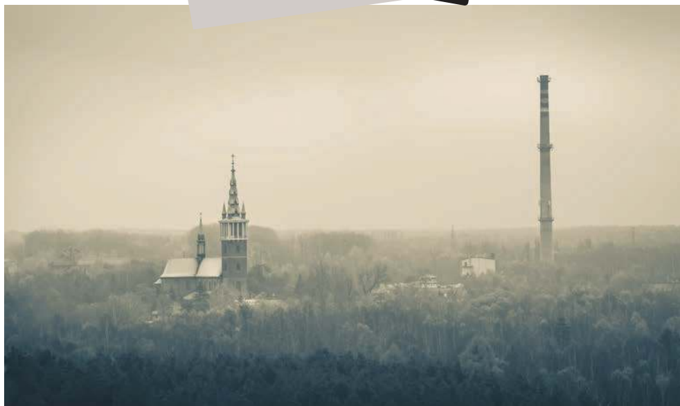
Kościół salwatorianów i nieczynna ciepłownia w Trzebinii
