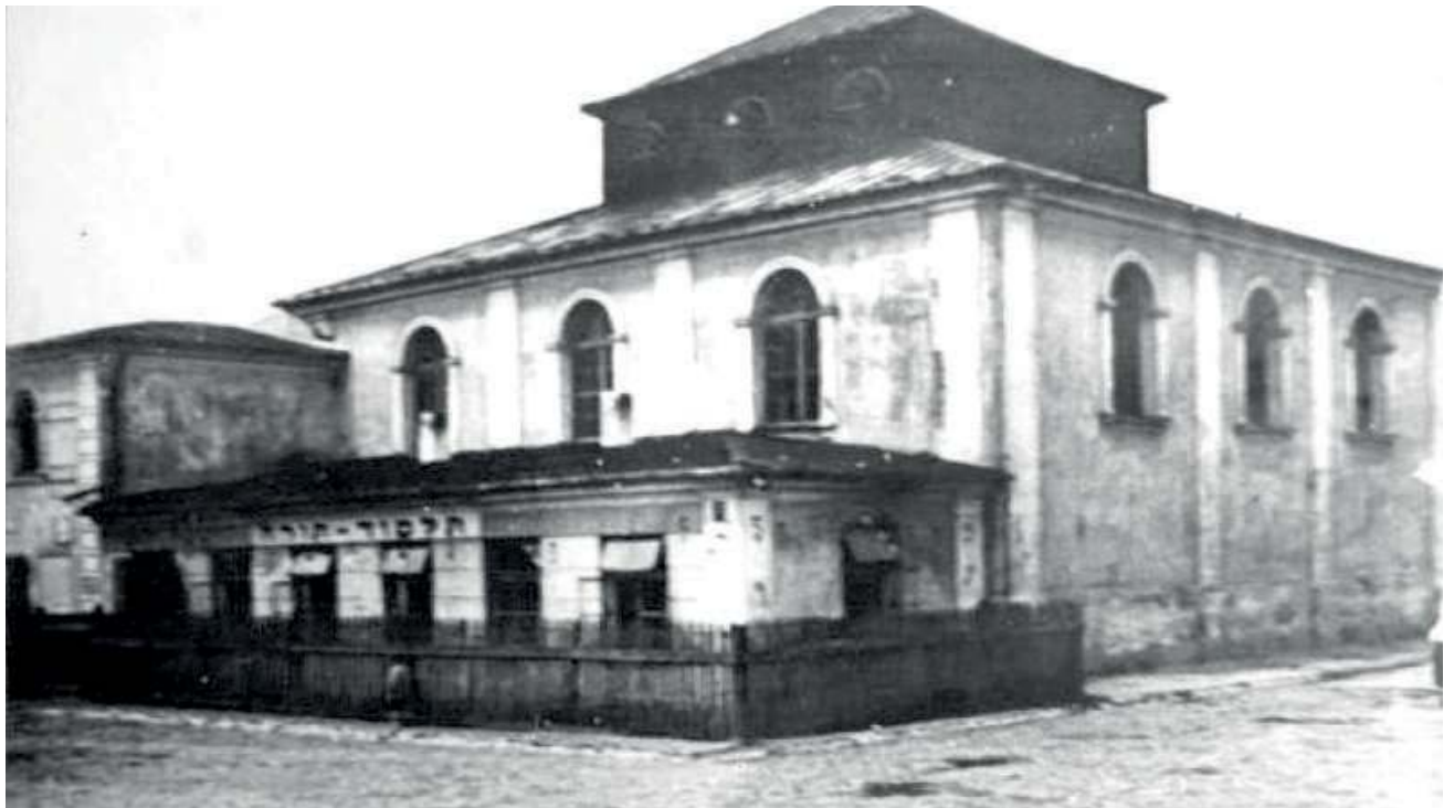
Widok na synagogę od strony ulicy Bożniczej (obecnie Zdanowskiego). Pochodzący z końcówki XVIII wieku budynek został zbombardowany przez Niemców w lipcu 1944
