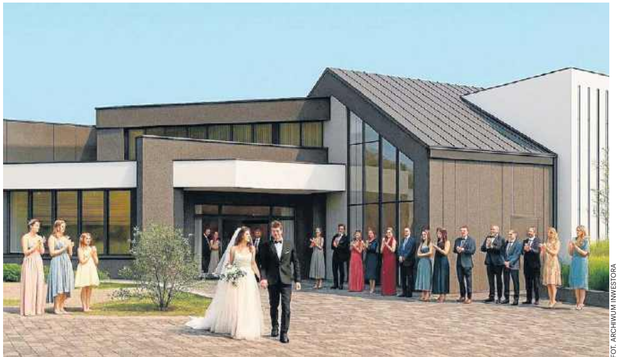
Galeria Przestrzeni w Busku-Zdroju. Obiekt wybudowany będzie zgodnie z założeniami stylu Bauhaus
