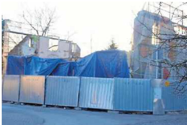
Ruszyły prace przy tworzeniu Parku Kulturowego Stary Radom. Rozebrano część budynku przy ulicy Piotrówka 19.
