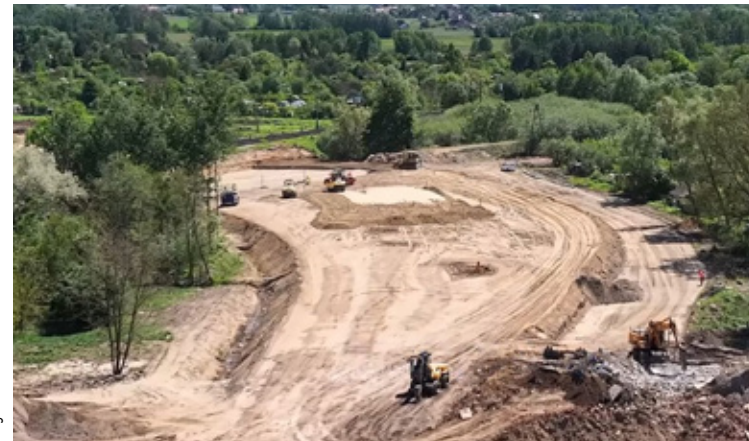
Gołym okiem nie widać jeszcze ogromnych postępów, bo większość pracy została wykonana pod powierzchnią.
