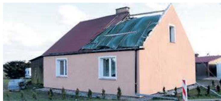
Budynek w Kosobudach-Wybudowaniu był niedawno odnawiany.
