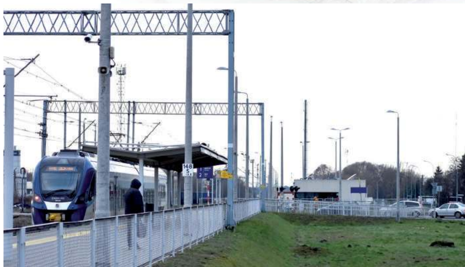
W 2025 roku kłopoty z korkami przy przejeździe kolejowym mają zniknąć na dobre
