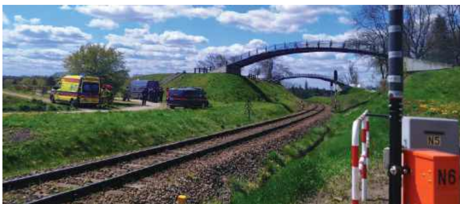
Jak poinformowała podkomisarz Dorota Krukowska-Bubiło, działania te mają charakter standardowej procedury stosowanej w przypadku ujawnienia tego typu nieprawidłowości lub niejednoznacznych elementów w obrębie infrastruktury kolejowej
