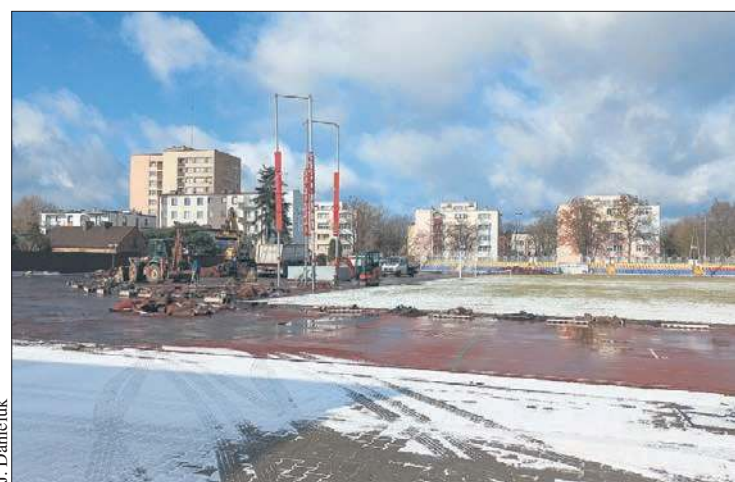
J. Danieluk Rozpoczęła się przebudowa Stadionu Miejskiego im. Bernarda Szymańskiego
