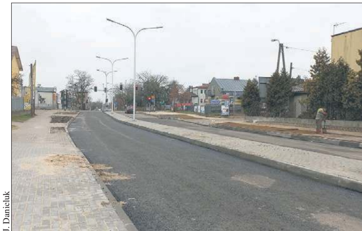
Prace na ulicy Spółdzielczej powinny zakończyć się do 15 marca, ale wykonawca wystąpił do urzędu miasta z wnioskiem o ponowne przedłużenie terminu
