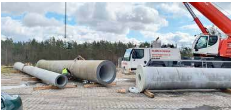
Trzy części konstrukcji, które w sumie ważą ponad 60 ton, czekają na instalację
