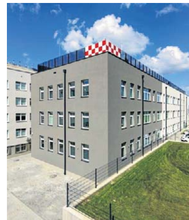
Blok operacyjny został dobudowany do istniejącego budynku „H”
