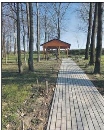
Nowa droga do budowanej altany
