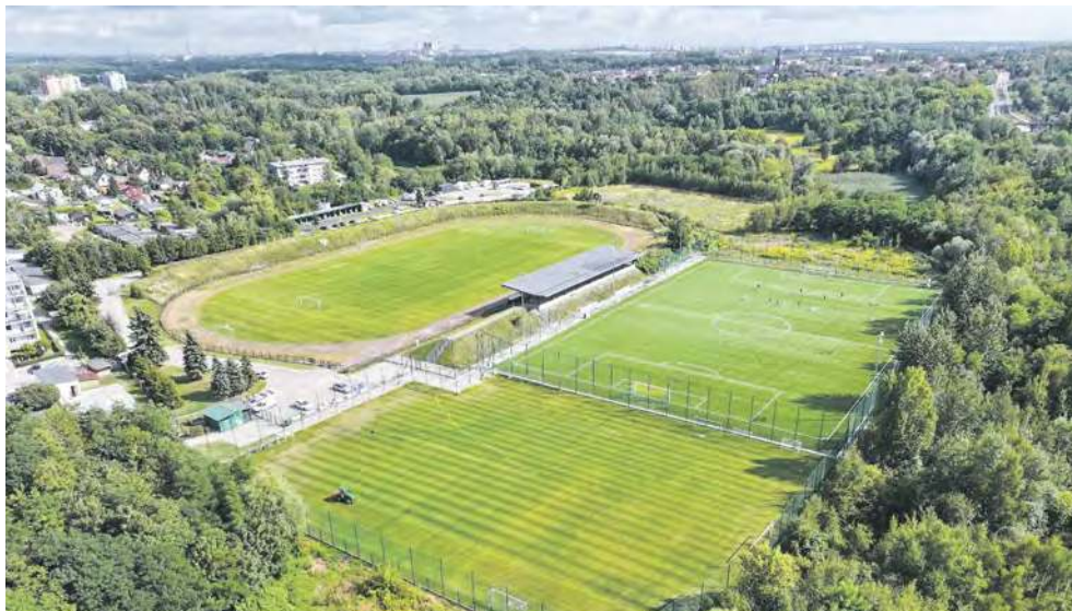
Projekt zakłada modernizację stadionu GKS Rozbark
