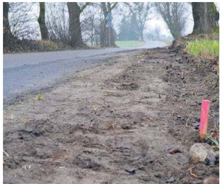
Prace przy drodze prowadzącej z Zielonej Huty do Konarzyny już się rozpoczęły. Inwestycja ma być zakończona do 30 czerwca.
