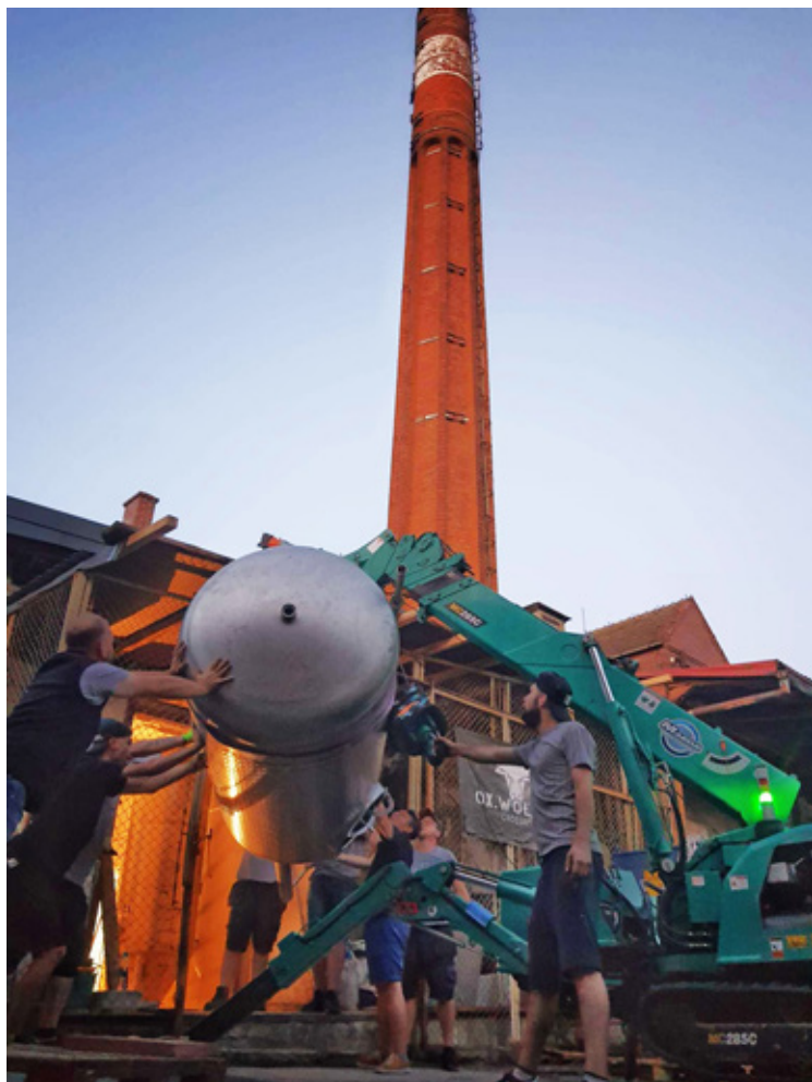
Montaż zbiorników już za ekipą.
