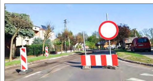
Ruszyła przebudowa przepustu na drodze powiatowej w Górznie. Droga będzie zamknięta prawie dwa miesiące
