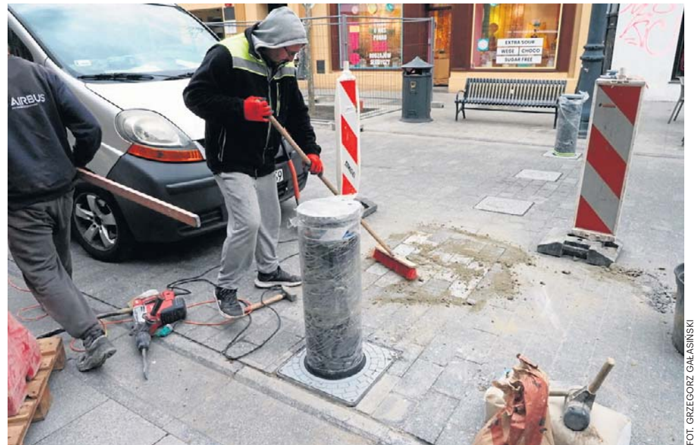
Słupek, który według dokumentacji powinien zatrzymać rozpędzony samochód, przewrócił się od trącenia przez auto dostawcze jadące z niską prędkością
