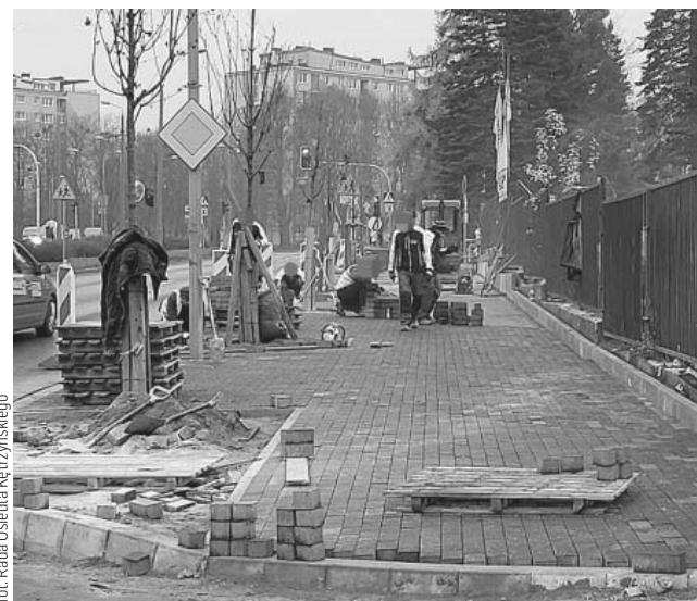
Budowa chodnika przy ul. Kętrzyńskiego w Olsztynie
